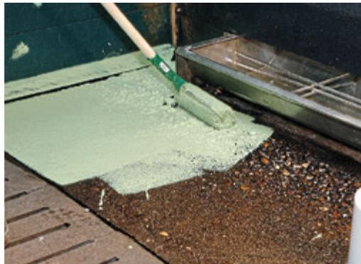
Aufgetragen wird die Grundierung am besten mit einer Rolle. Zusätzlich wird insbesondere bei rauen Böden das Aufbürsten mit dem Besen empfohlen. Den Verbrauch haben wir mit 300 g/m<sup>2</sup> ermittelt, so dass ein 4,5-kg-Gebinde für Flächen von bis zu 15 m<sup>2</sup> ausreicht. Gut finden wir, dass sowohl die Grundierung als auch die Versiegelung jetzt serienmäßig rutschhemmend eingestellt sind.
