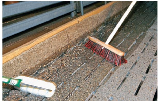
Am Tag nach dem Auftragen der Grundierung kann der Auftrag des grün eingefärbten Bodenschutzes erfolgen. Die Viskosität des Materials ist so eingestellt, dass es sich leicht mit der Rolle verteilen lässt. Mit einem nicht zu rauen Boden beträgt so der Verbrauch rund 300 g/m<sup>2</sup>. Raue Untergründe wie dieser erhöhen den Verbrauch dagegen massiv. Mit Blick auf die Haltbarkeit sollte bei solch vorgeschädigten Böden besser zuvor ein Saniermörtel aufgetragen werden.
