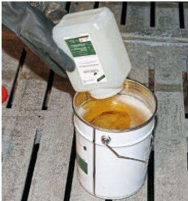
Wie alle Epoxidharz-Versiegelungen verlangt auch der Farmfloor Bodenschutz vorab das Grundieren des Bodens. BEG Schulze Bremer verkauft die Bodenversiegelung nur im Paket, so dass der Lieferung immer gleich die Grundierung mit beiliegt – in diesem Fall in Form eines 4,5 kg kleinen Gebindes.
